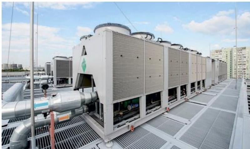
**Рисунок Б.2 – Холодильная машина с воздушным охлаждением конденсатора**
